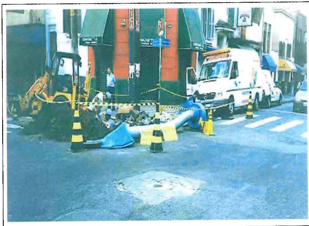
Figura 6 – Isolamento com fitas e cones zebraados, contenção através de mantas absorventes e monitoramento ambiental.
